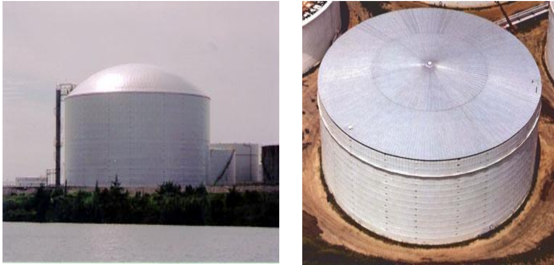
الشكل (1-1) يبين الشكل خزان بسقف الثابت على شكل قبة على اليسار، و على اليمين خزان بسقف مخروطي [27]
